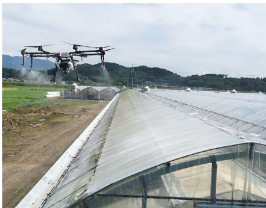
ドローンによる吹き付け作業
